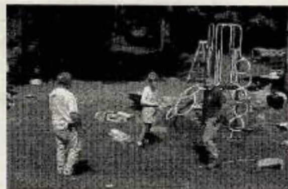
Assemble, dig holes, pour concrete - done!
