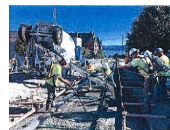
Build Forms & Pour Concrete
